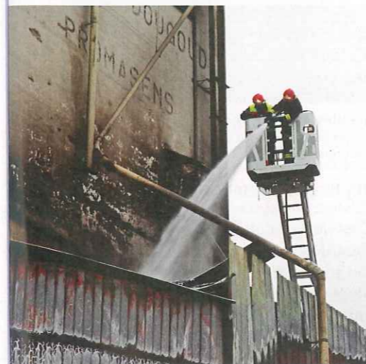
Mission de refroidissement depuis l'échelle automobile.
